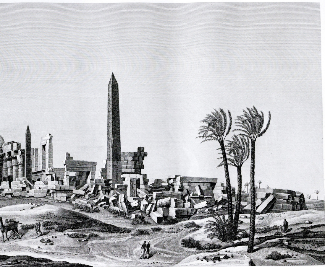
VUE DES RUINES DE LA SALLE HYPOSTYLE ET DES APPARTEMENS DE GRANIT DU PALAIS.
